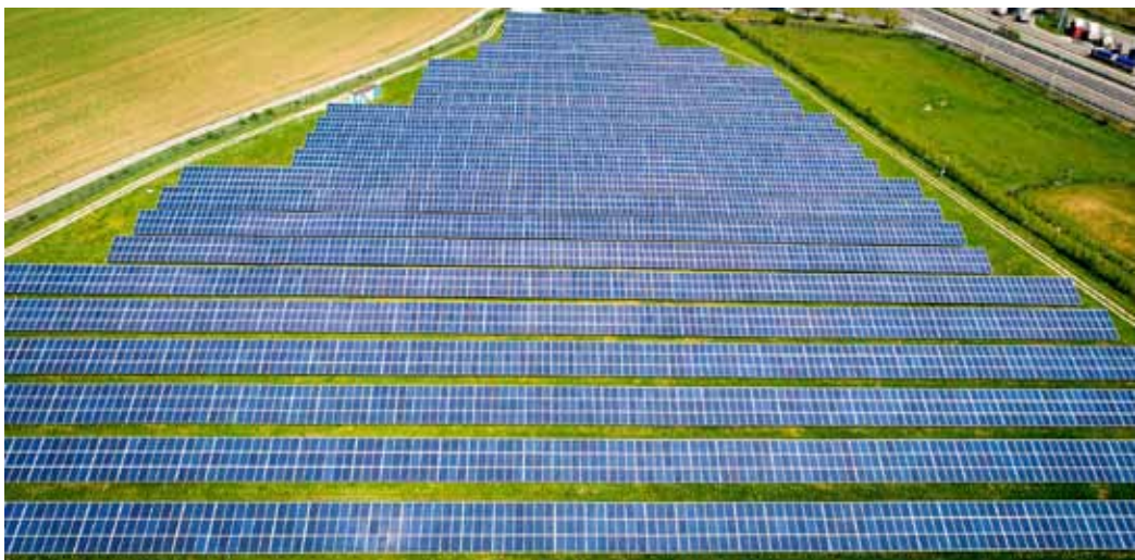
Sonnedix's Novi Ligure Solar solar plant.
